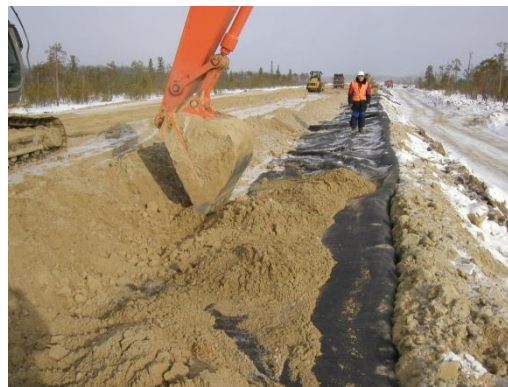
Рис.4 Преднапряжение геоткани техникой.
