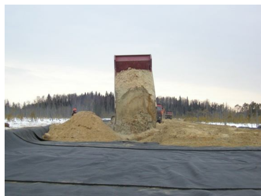
Рис.2 Отсыпка и уплотнение слоя насыпи.
