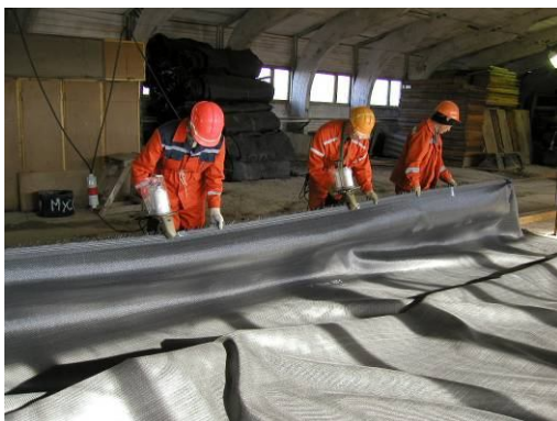
Рис.1 Сшивка геоткани.
