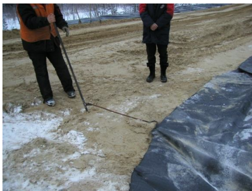
Рис.3 Преднапряжение геоткани техникой.
